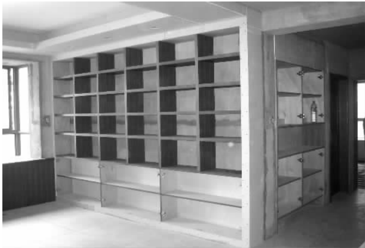
配图为工地现场
